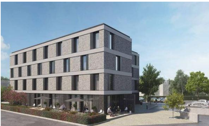
AKZENT Hotel DÉJANIL / Burgdorf
